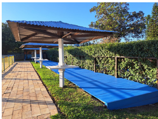
substituição e pintura deck area piscinas
