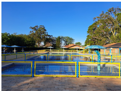
área piscinas concluída
