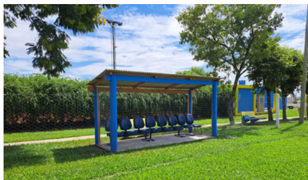
construção de 02 casamatas
