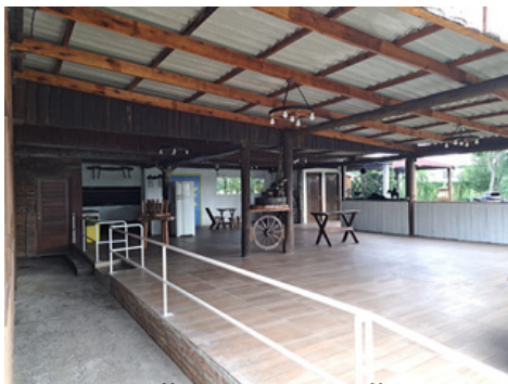
instalação de corrimão para segurança
